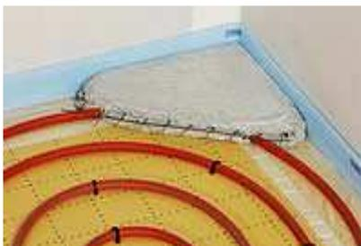
3. Mise en place de la dalle flottante, sur l'ensemble **TMS MF** + élément chauffant + treillis.
