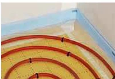
2. Mise en place de l'élément chauffant, directement fixé sur le **TMS MF**, facilité par le quadrillage.
